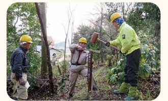
里山遊歩道道標取付け
