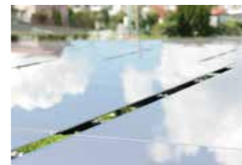
住宅街の中にある「宝塚すみれ発電所 第2号」
